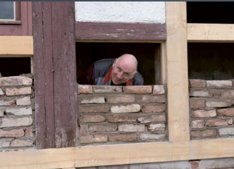
Gunter Schuchardt mit großer Freude bei der Renovierung des Ziegenstalls
